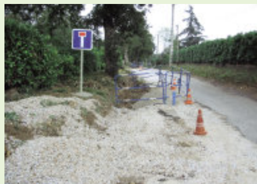
Remplacement de conduite d'eau
