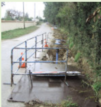
Remplacement de conduite d'eau
