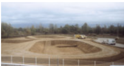
Ça y est ! Depuis le 17/10/01, les travaux de la future station d'épuration par procédé
